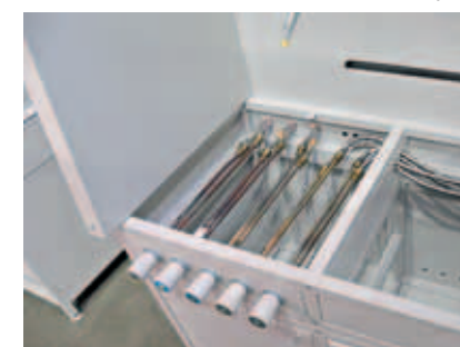
Краны и гибкие подводки для подачи газа, воды, вакуума, сжатого воздуха с дистанционным управлением с передней панели шкафа
